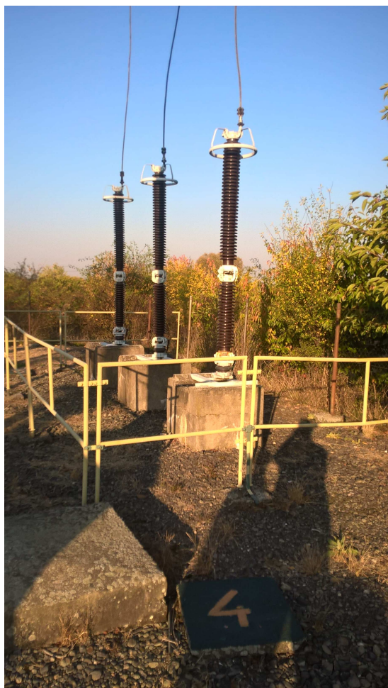
Obr.6 – Pohled na připojení ventilových bleskojistik 110 kV na linku V961
