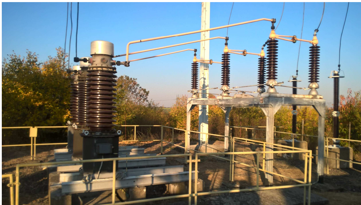
Obr.8 – Pohled na pole linky V961 a připojení přístrojových transformátorů 110 kV z odpojovače 110 kV trubkami, ocelové konstrukce pod přístrojovými transformátory 110 kV a pomocná ocelová konstrukce pro odpojovač 110 kV.
