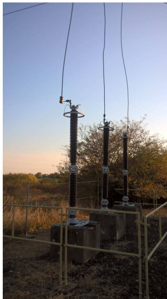
Obr.7 – Pohled na připojení ventilových bleskojistik 110 kV na linku V962
