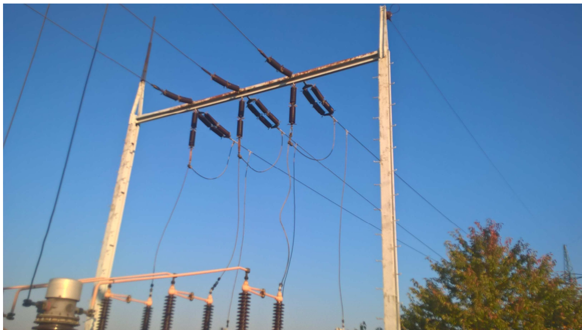
Obr.5 – Pohled na ukotvení link V961 na portále a připojení bleskojistik a odpojovače na vodiče linky pomocí lanových klesaček.
