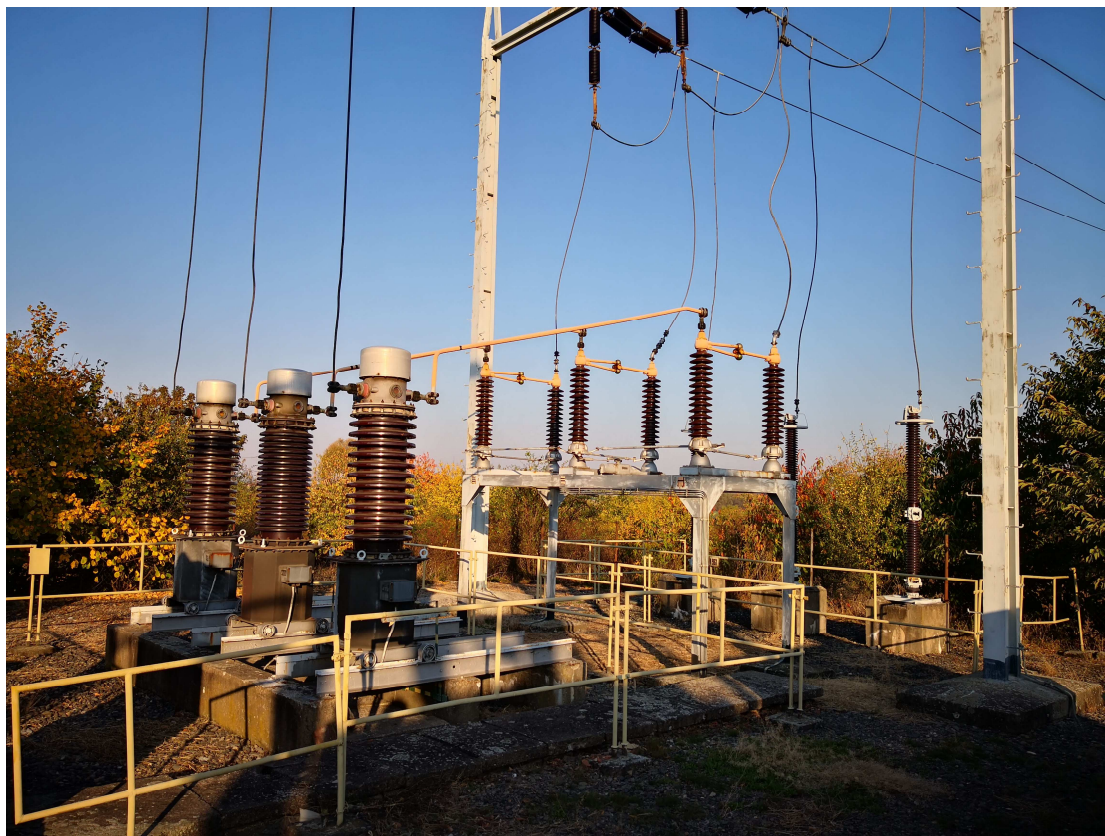
Obr. 3 – Pohled na pole rozvodny 110 kV napájené z linky V961. Zprava jsou ventilové bleskojistky 110 kV, horizontální 3-pólový odpojovač 110 kV a přístrojové transformátory proudu 110 kV.
