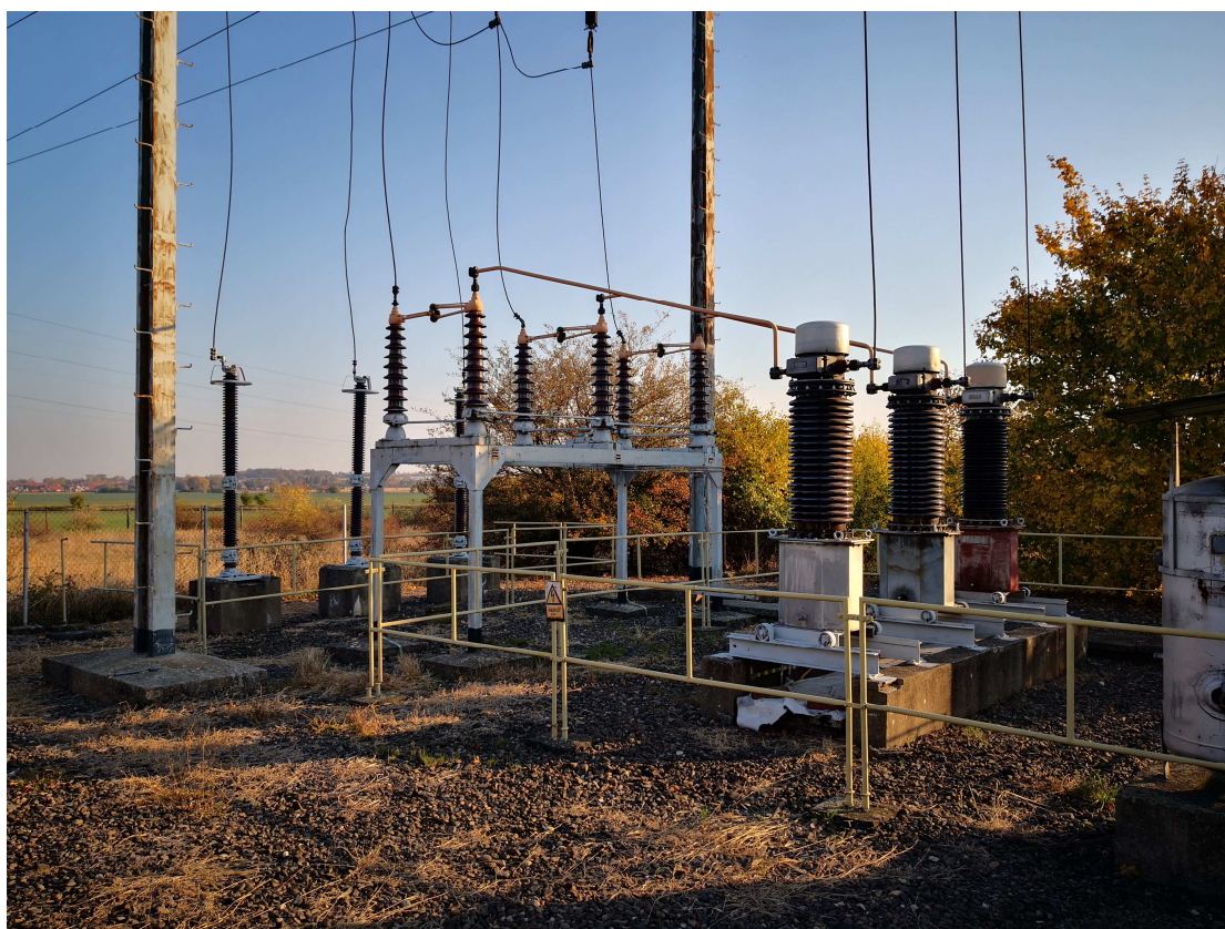
Obr.4 – Pohled na pole rozvodny 110 kV napájené z linky V962. Zleva jsou ventilové bleskojistky 110 kV, horizontální 3-pólový odpojovač 110 kV a přístrojové transform. proudu 110 kV.
