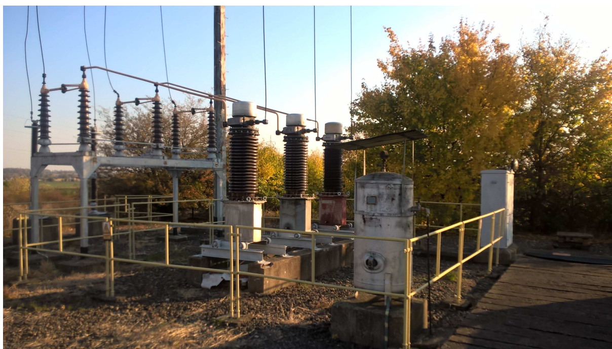
Obr.12 – Pohled na pole linky V962 a připojení přístrojových transformátorů 110 kV z odpojovače 110 kV trubkami, ocelové konstrukce pod přístrojovými transformátory 110 kV a pomocná ocelová konstrukce pro odpojovač 110 kV..Vpravo je ovládací skříň pole. V popředí ve vzduchojem rozvodu stačeného vzduchu pro ovládání odpojovačů 110 kV.
