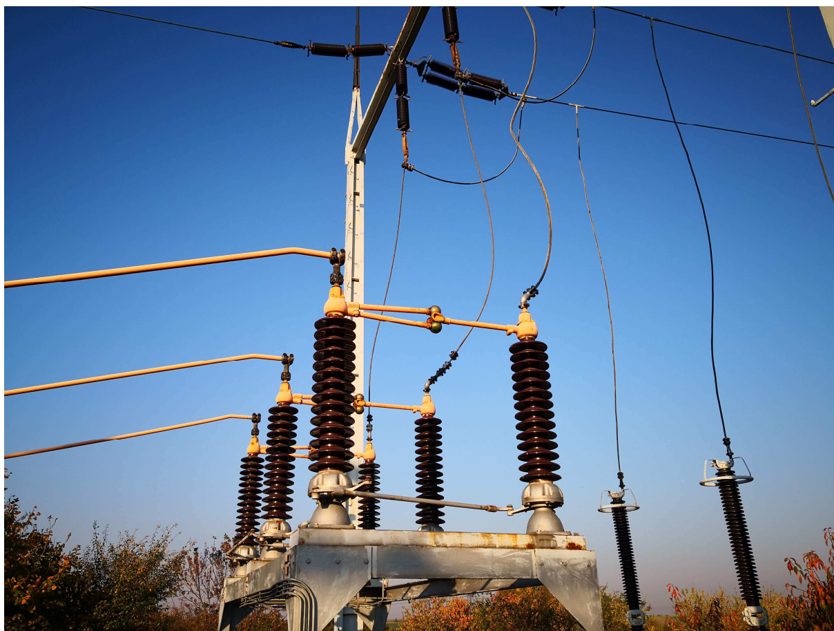
Obr.9 – Pohled na připojení odpojovače 110 kV linky V961.
