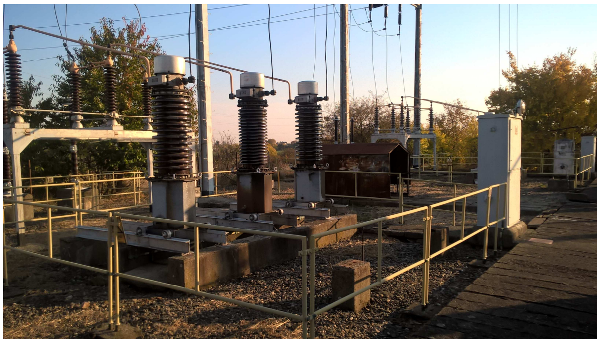
Obr.11 – Pohled na přístrojové transformátory linky V961 a připojení přístrojových transformátorů 110 kV z odpojovače 110 kV trubkami, ocelové konstrukce pod přístrojovými transformátory 110 kV a pomocná ocelová konstrukce pro odpojovač 110 kV..Vpravo je ovládací skříň pole vývodu na linku V961.
