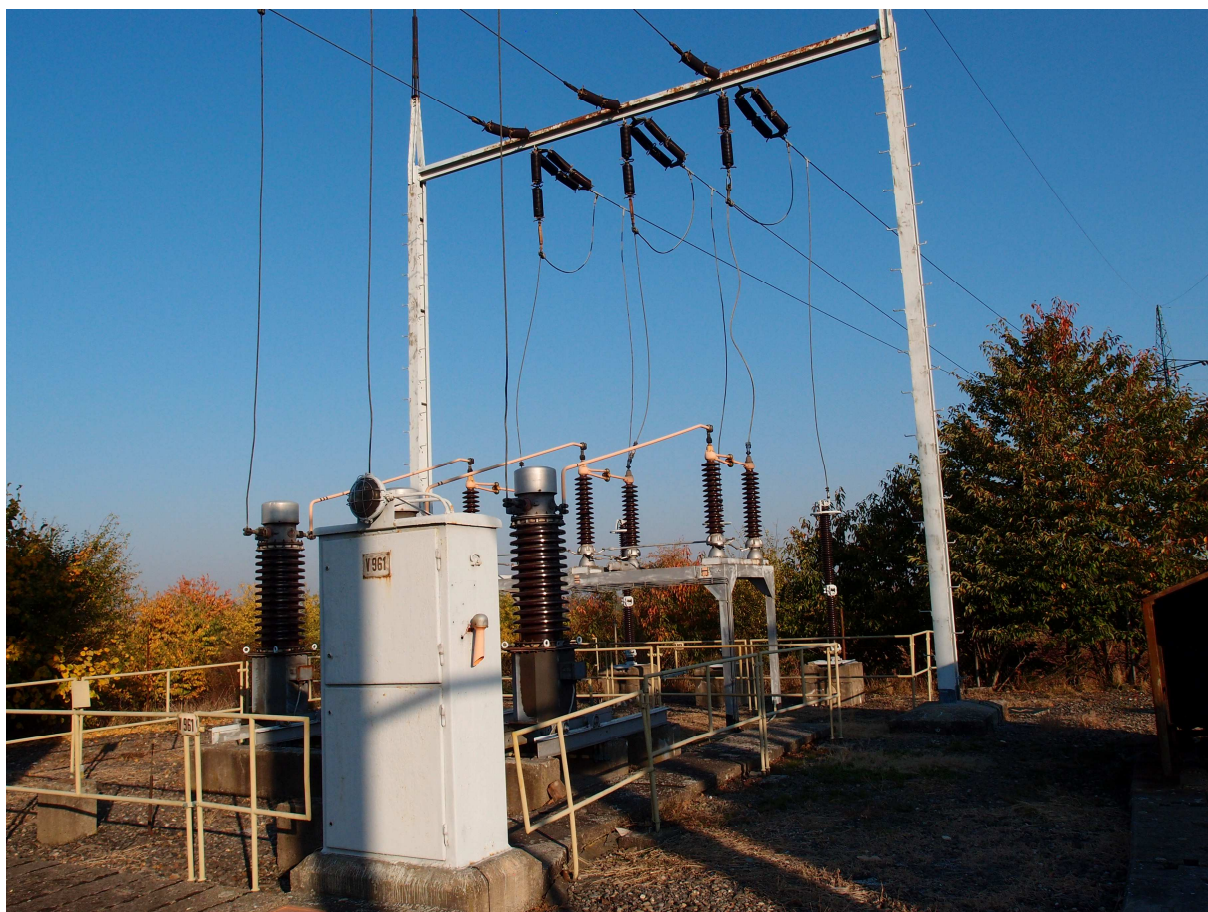
Obr.12 – Pohled na ovládací skříň pole linky V961 v poli vývodu na linku V961
